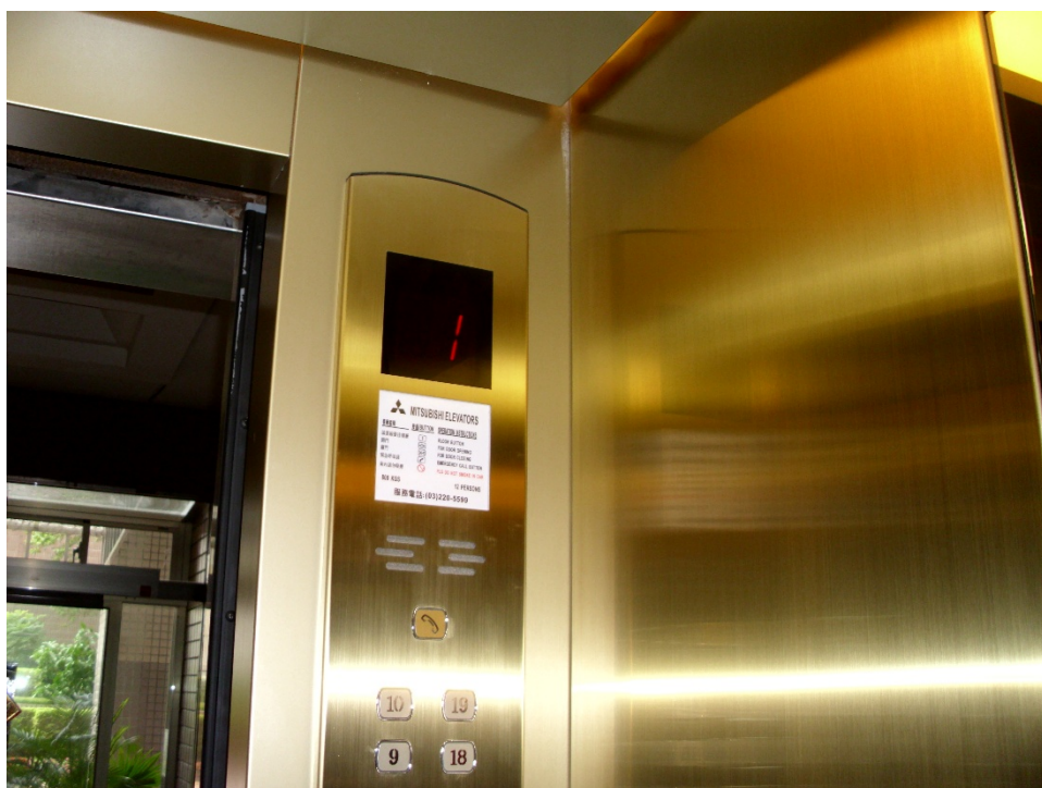
車廂改造後（壁板、操作盤髮紋不鏽鋼鍍鈦鍍色）
