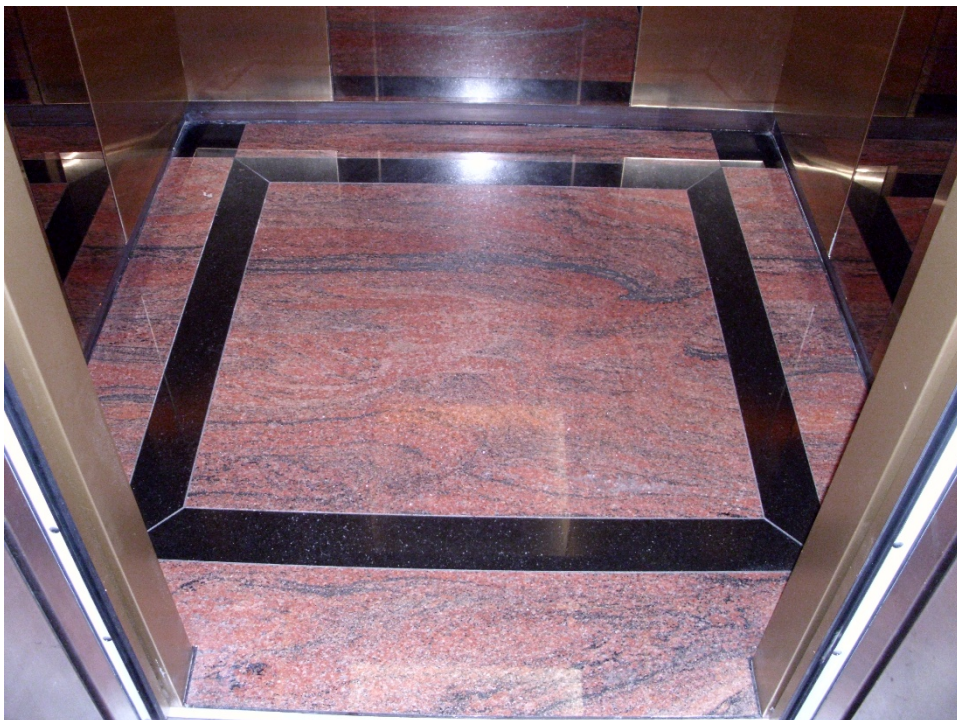
三菱電梯車廂地板更換後（大理石拼接）
