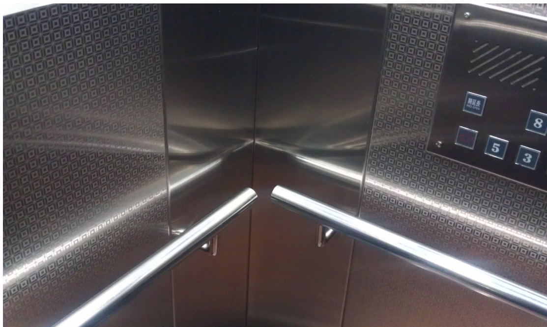
車廂壁板重新製作（髮紋不鏽鋼板加蝕刻圖案）
