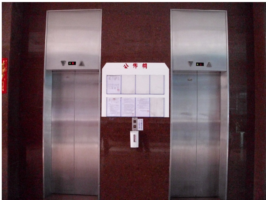
壹樓乘場門改造前
