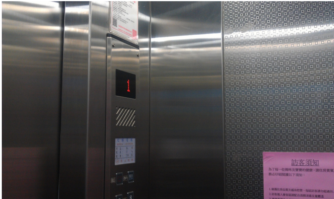
車廂壁板、內門板拆掉重新製作
