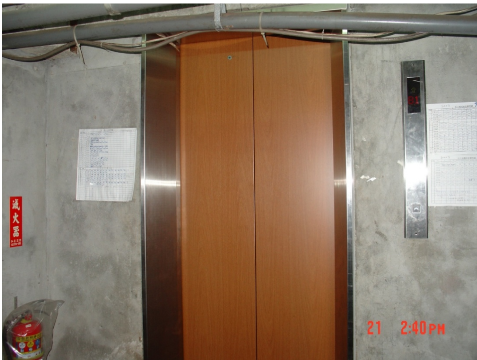
髮紋不鏽鋼包覆門框及更新乘場門板（彩妝鋼板）
