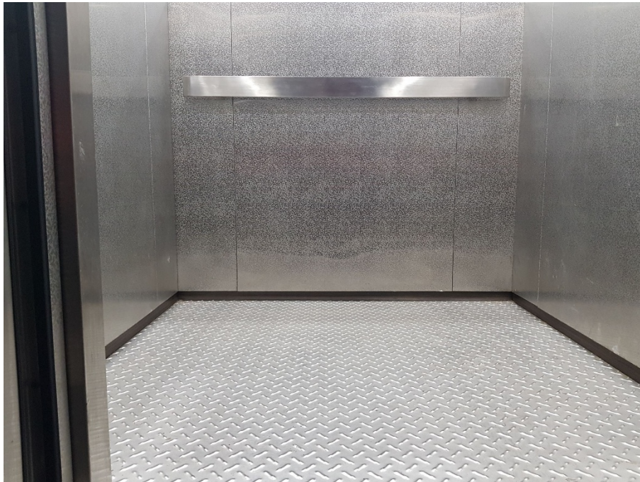
元璿電梯改造後之車廂另加裝一支扶手
