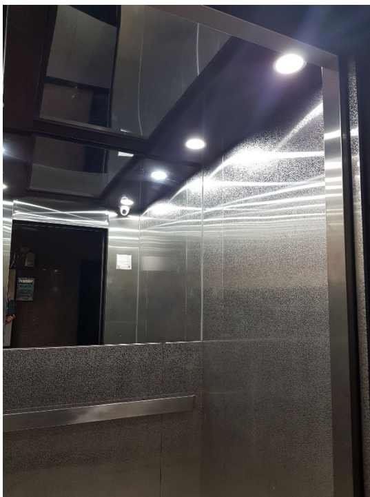
元璿電梯裝修後（車廂壁板面貼）
