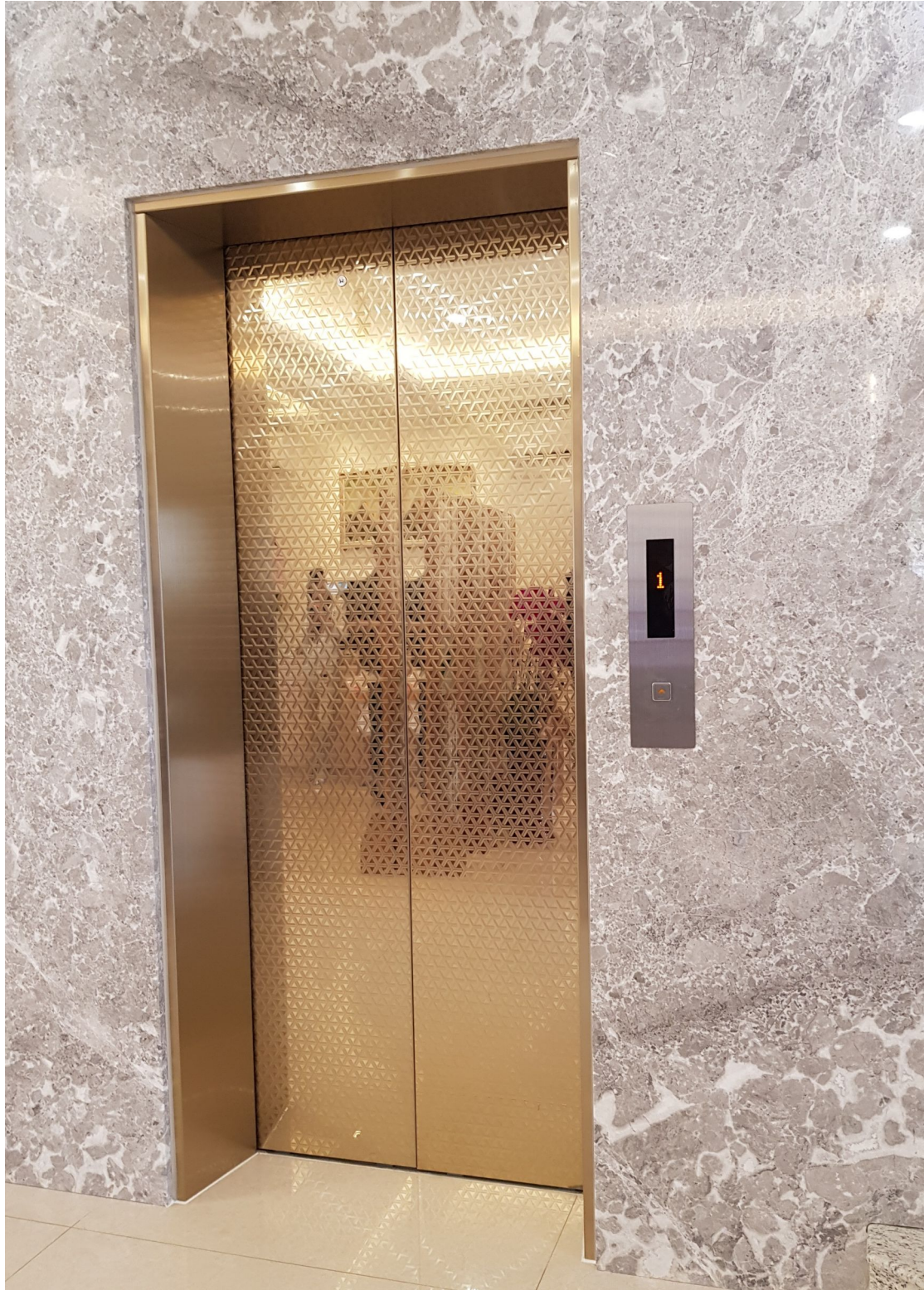
壹樓乘場門板髮紋不鏽鋼鍍鈦雷射 3D 蝕刻
