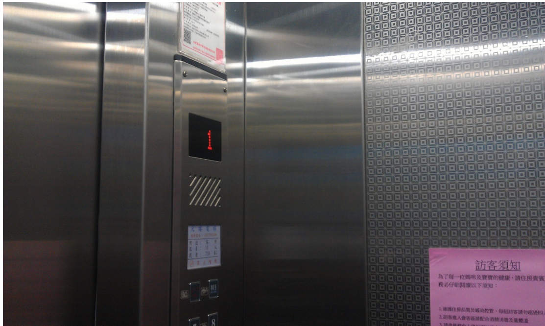
車廂壁板、內門板拆掉重新製作
