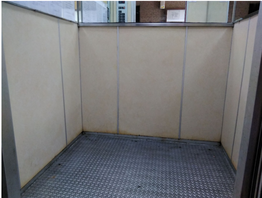
永大電梯：車廂壁板&地板改造前
