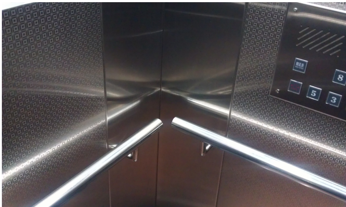
車廂壁板重新製作（髮紋不鏽鋼板搭配蝕刻圖案）
