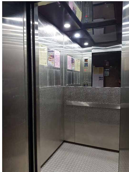
元璿電梯裝修後（車廂壁板面貼）
